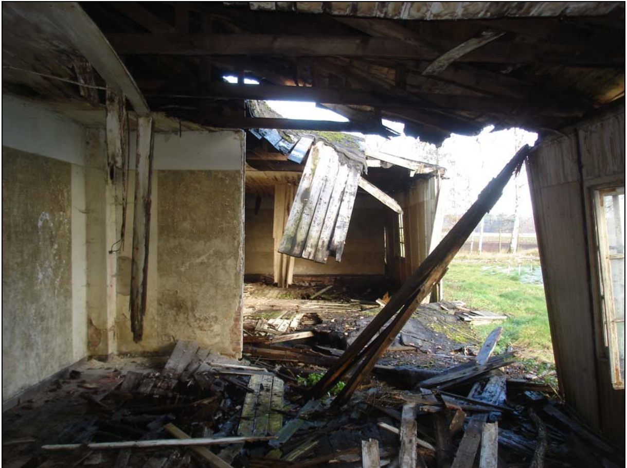
Ehemalige Unterkunftsbaracken, Blick in Baracke z2. Foto: Andreas Ehresmann, 15.11.2007.
