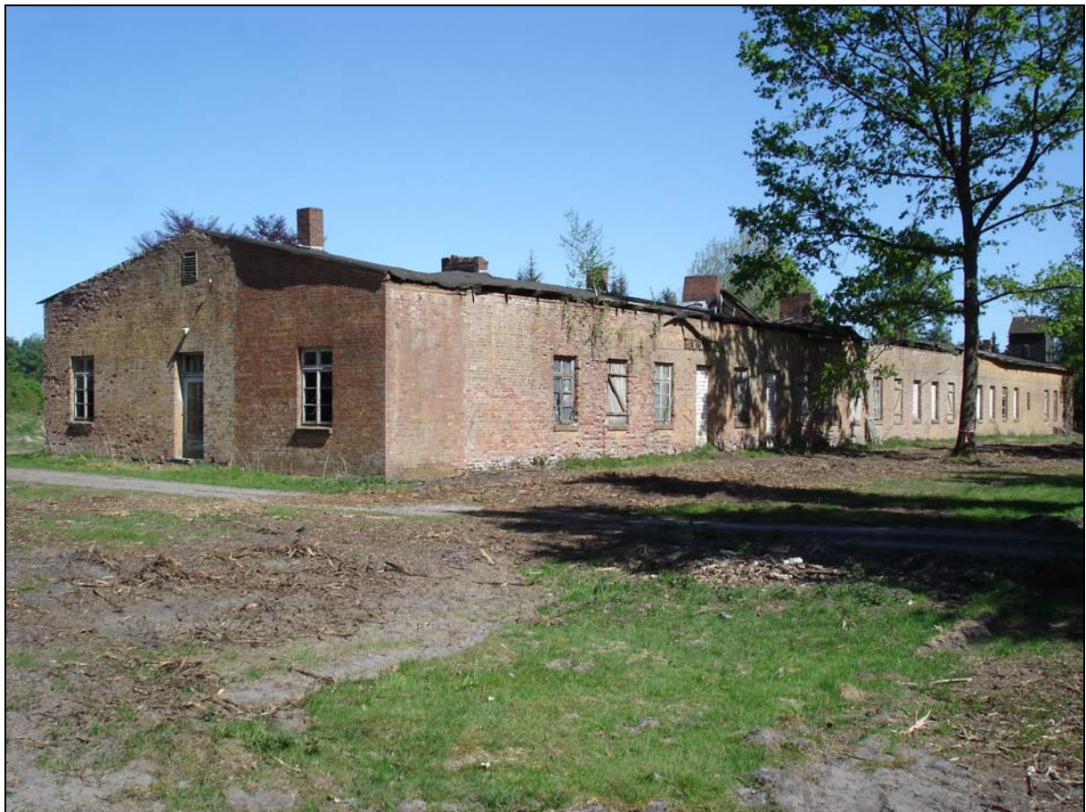
Ehemalige Lagerküche B, Blick auf den Hauptbaukörper. Foto: Andreas Ehresmann, 29.4.2007.
