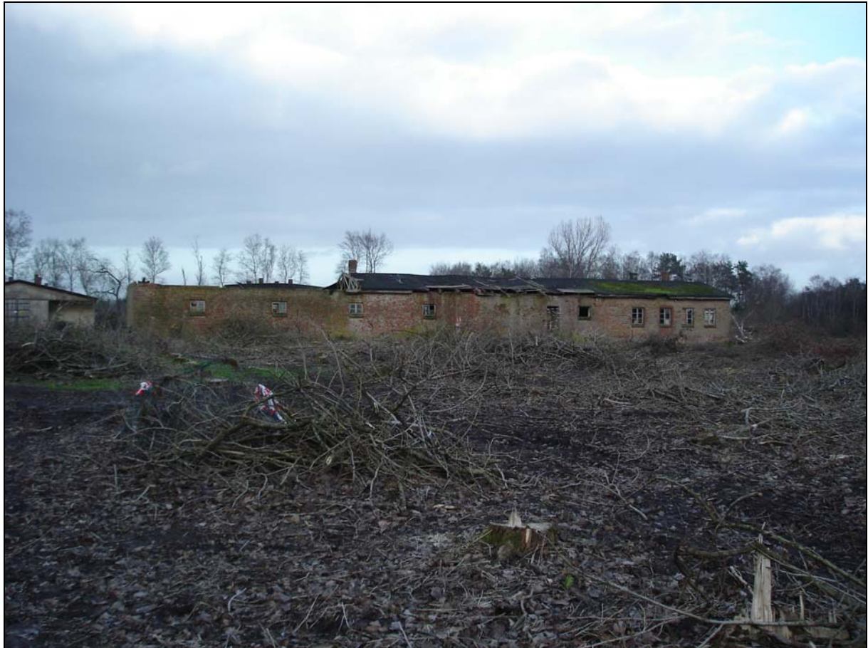
Ehemalige Latrine (rechts), Ansicht von Süden. Foto: Andreas Ehresmann, 18.4.2007.
