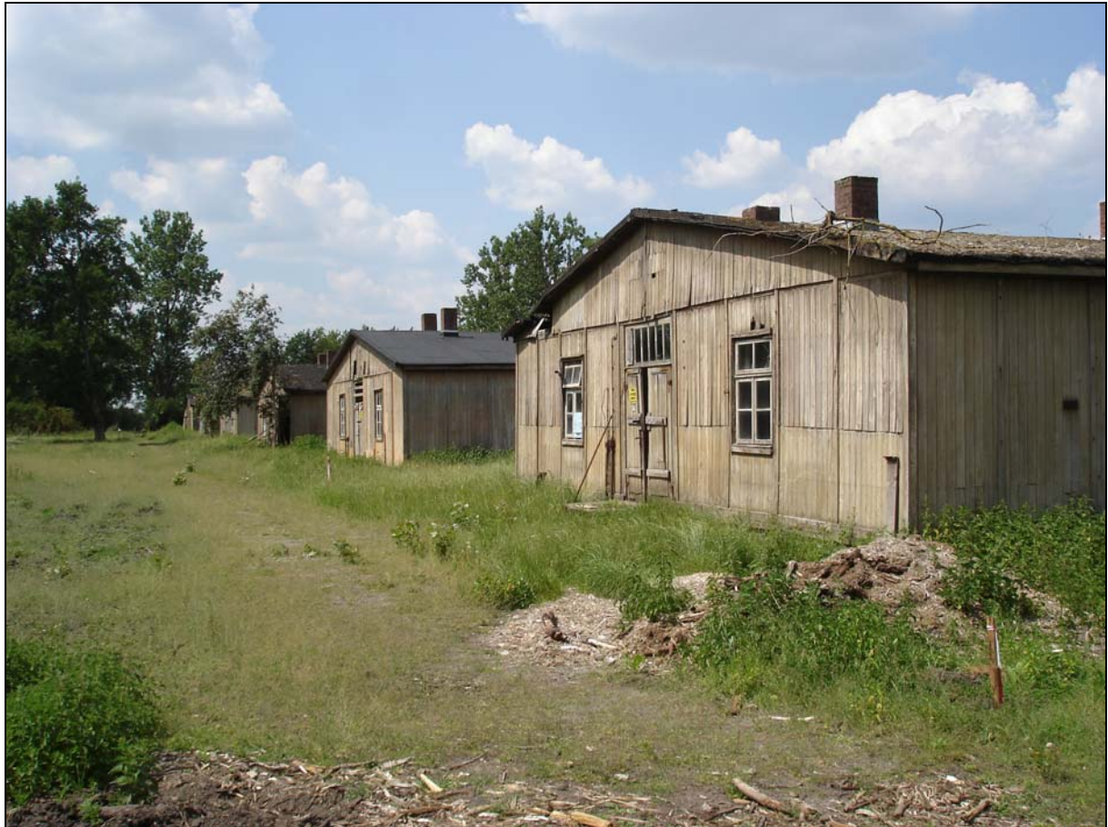
Ehemalige Unterkunftsbarracken, Blick von Osten. Foto: Andreas Ehresmann, 11.6.2007.
