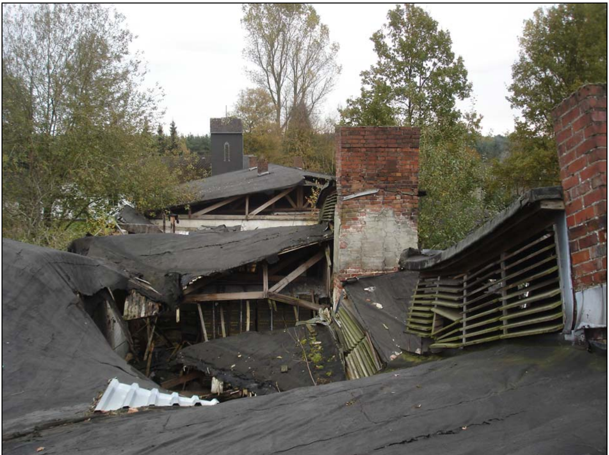
Ehemalige Lagerküche, Blick auf das Dach. Foto: Andreas Ehresmann, 20.10.2007.
